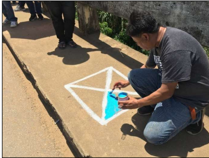
รูปที่ 5 แสดงการทำหมุดควบคุมทางราบ
