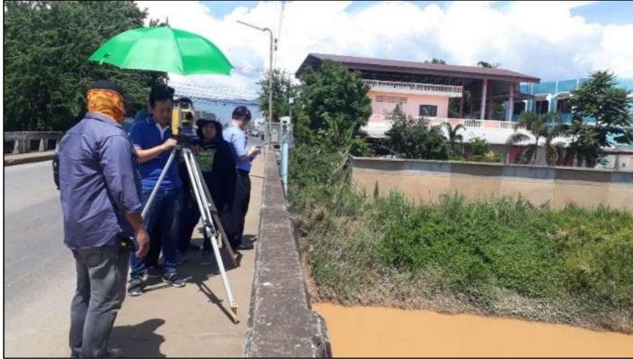
รูปที่ 7 แสดงการสำรวจตำแหน่งพิกัดจุดควบคุม โดยวางรอบด้วยกล้อง Total Station
