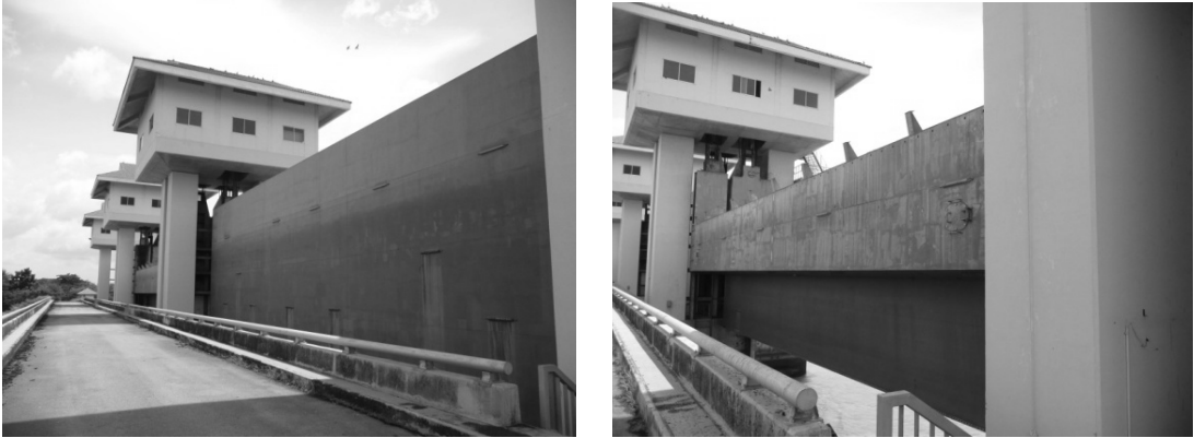
Single leaf wheel gate มีหน้าตัดขนาดเดียว
