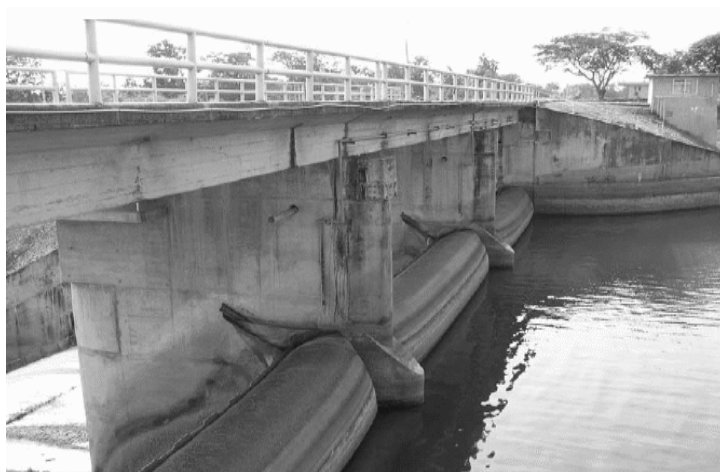
รูปที่ 8.9-7 แสดงการติดตั้งฝายยางชนิดสูบลมอัดด้วยลม เสริมสันอาคารระบายน้ำล้นโครงการอ่างเก็บน้ำลำปาว จังหวัดกาฬสินธุ์ ยึดขอบข้างปลายถุงยางที่พับโค้งไปทางท้ายน้ำกับตอม่อ
