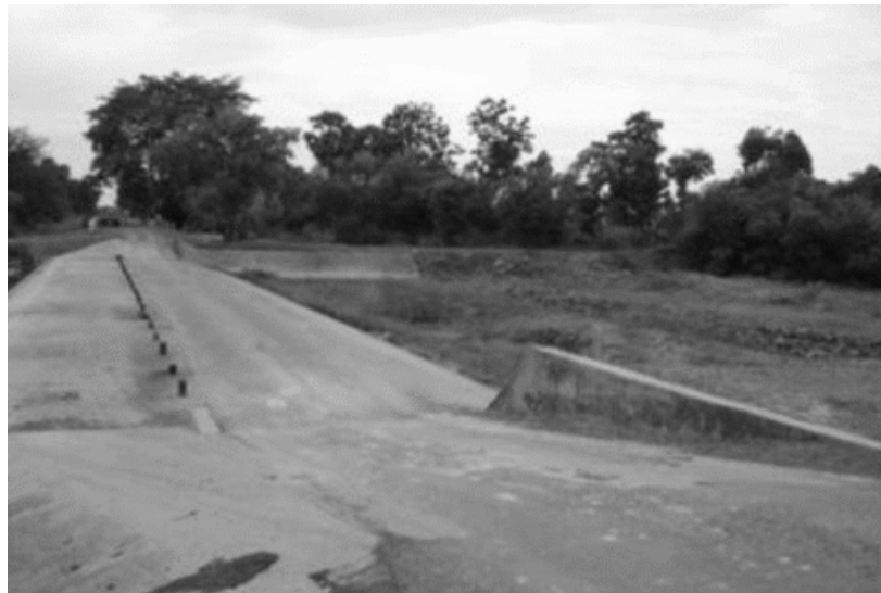
รูปที่ 8.7-1 ลักษณะของฝายหน้าตัดรูปสี่เหลี่ยมคางหมู ตามแนวสันฝาย
