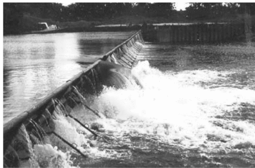
ฝายพับ แบบ Flap gates
