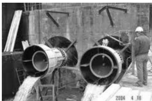
รูปที่ 13-27 แสดงตัวอย่างของอาคารOutlet ที่ควบคุมด้วย Fixed cone valve
