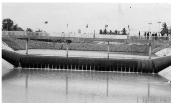
รูปที่ 8.9-8 แสดงการติดตั้งฝายยางที่ขอบฐานรองรับด้านข้างเป็นลาด รูป 1 ปลายถุงยางเป็นแนวตรงขึ้นไปตามลาด รูป 2 ปลายถุงยางที่พับโค้งไปทางท้ายน้ำ
