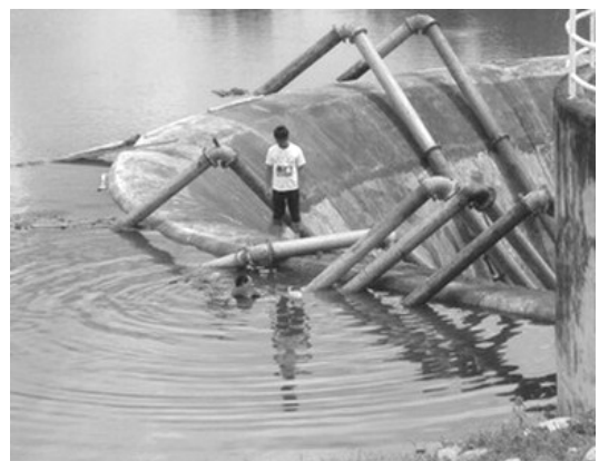
รูปที่ 13-56 การติดตั้งกาลักน้ำที่ทางระบายน้ำสันอ่างเก็บน้ำแม่มาน จังหวัดแพร่
