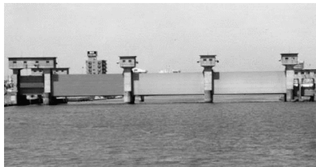
เขื่อนระบายน้ำที่ควบคุมด้วย Long span leaf wheel gate
