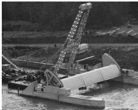
รูปที่ 12-8 ควบคุมด้วยบานโค้ง (Radial หรือ Tainter gate)
