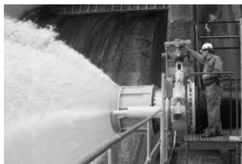
รูปที่ 13-27 แสดงตัวอย่างของอาคารOutlet ที่ควบคุมด้วย Fixed cone valve
