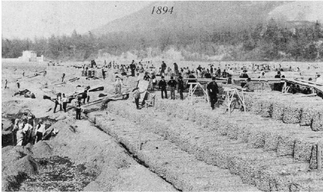
รูปที่ 8.8-2 การใช้งาน Gabion เพื่อป้องกันการกัดเซาะของแม่น้ำ Reno ในประเทศอิตาลี
