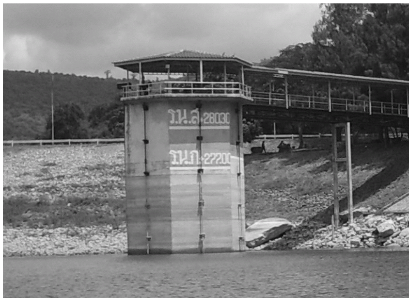
รูปที่ 13-29 อาคาร Outlet work ของเขื่อนลำตะคอง จังหวัดนครราชสีมา ที่มีอาคารทางเข้าแบบเปียก (Wet intake tower)
