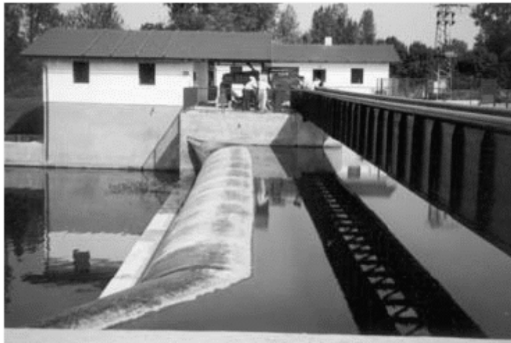
รูปที่ 12-9 ฝายยาง (Rubber weir หรือ Rubber dam) ได้อธิบายแล้วในหัวข้อ 8.9
