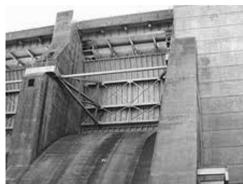
รูปที่ 12-8 ควบคุมด้วยบานโค้ง (Radial หรือ Tainter gate)
