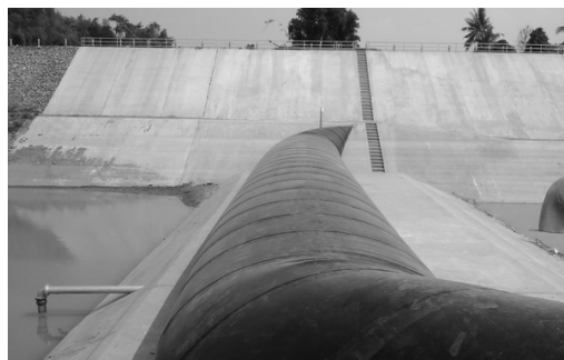
รูปที่ 8.9-8 แสดงการติดตั้งฝายยางที่ขอบฐานรองรับด้านข้างเป็นลาด รูป 1 ปลายถุงยางเป็นแนวตรงขึ้นไปตามลาด รูป 2 ปลายถุงยางที่พับโค้งไปทางท้ายน้ำ
