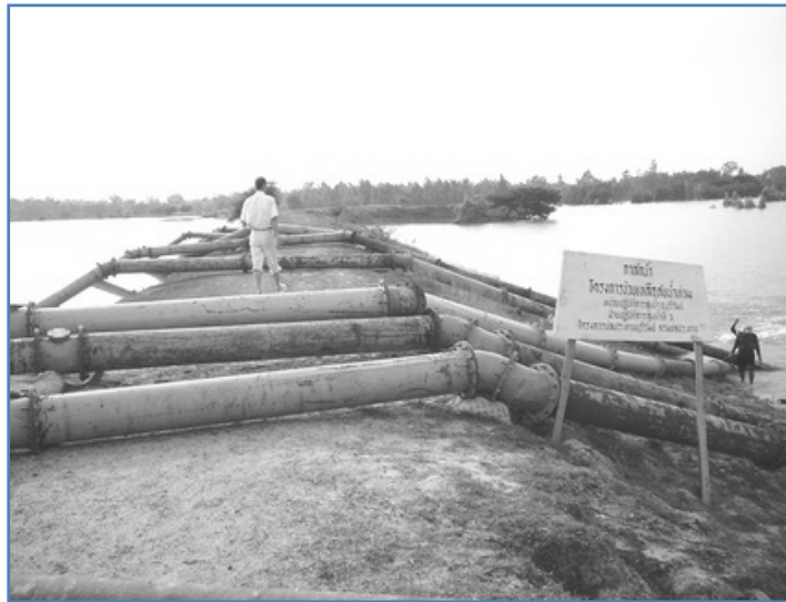
รูปที่ 13-57 การติดตั้งกาลักน้ำที่ทำนบดินเพื่อช่วยพร่องน้ำ จากอ่างเก็บน้ำลำตะโค่ง จังหวัดบุรีรัมย์
