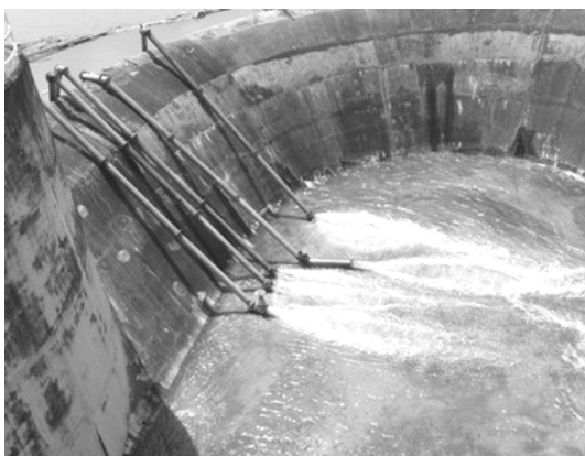
รูปที่ 13-56 การติดตั้งกาลักน้ำที่ทางระบายน้ำสันอ่างเก็บน้ำแม่มาน จังหวัดแพร่
